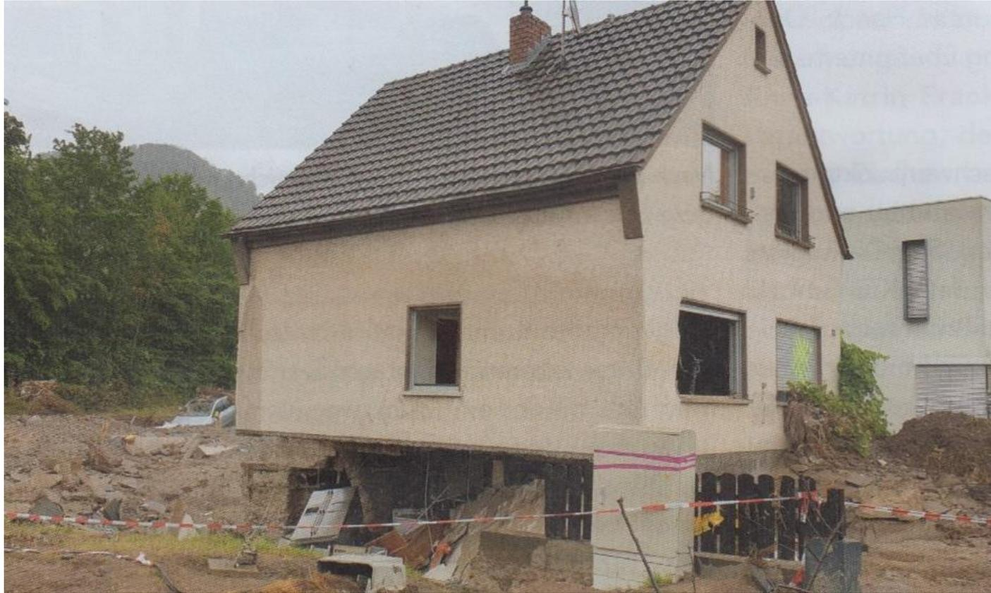
Erosionsschaden nach dem Hochwasser 2021 im Ahrtal
